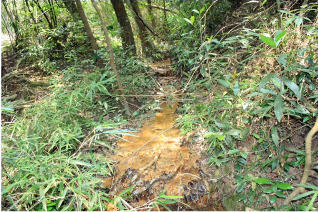
開挖引致的泥地
