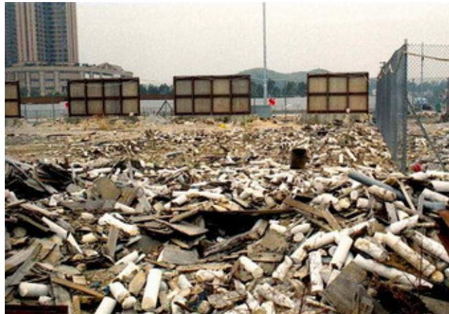
圖 7 元朗雞地工程施工中廢棄的大理岩岩芯
